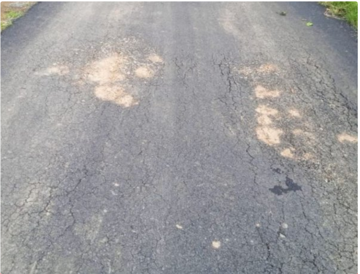
Foto: Aspal Jalan sepanjang 645 meter yang didanai oleh Bantuan Keuangan (Bankeu) Provinsi Jawa Tengah 2024.
