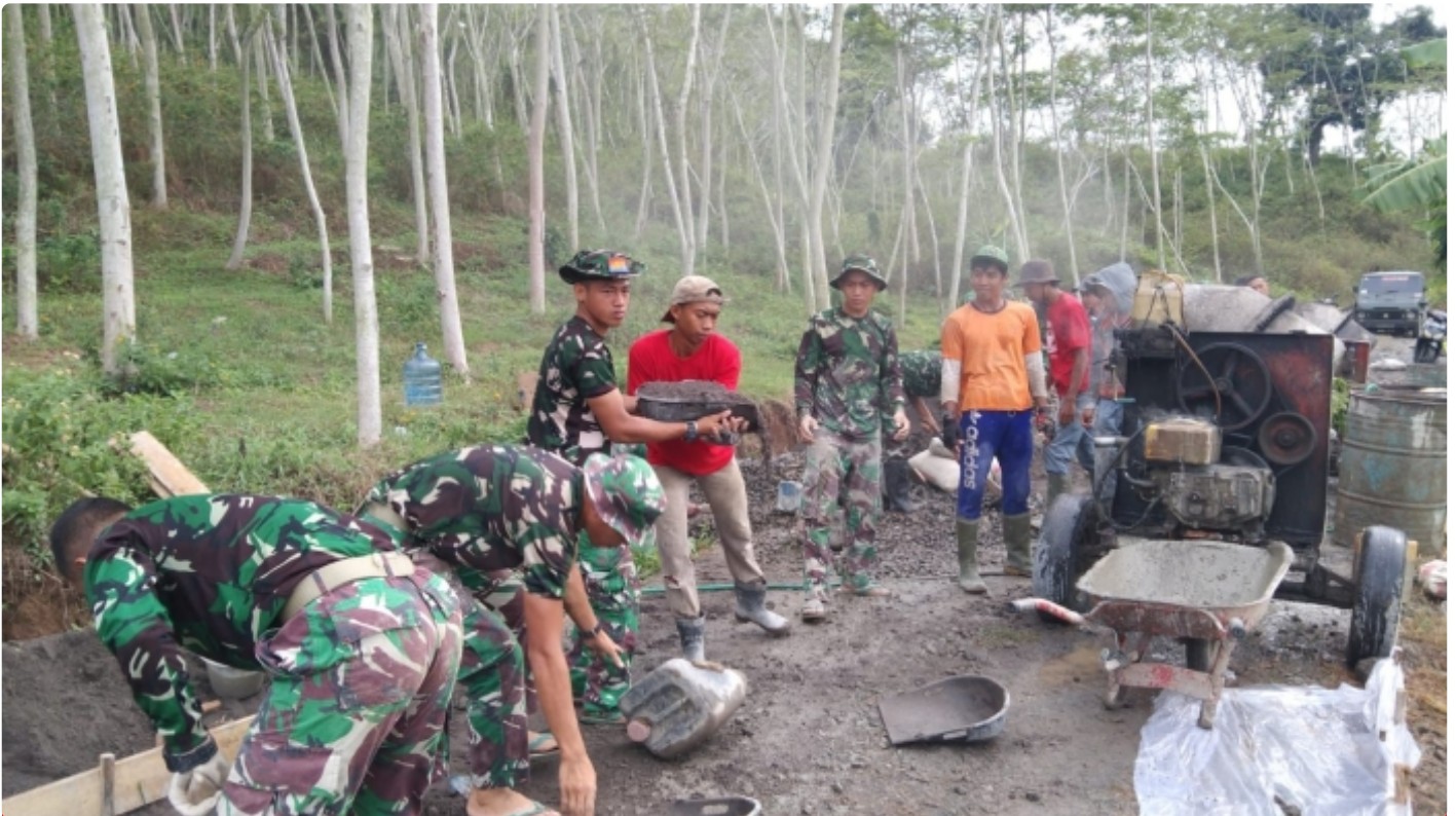
Satgas TMMD Bersama Warga Bangun Pengecoran Jalan Penghubung Dukuh Grobogan Ke Area Pertanian.
